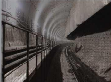
Строительство второго Байкальского тоннеля
