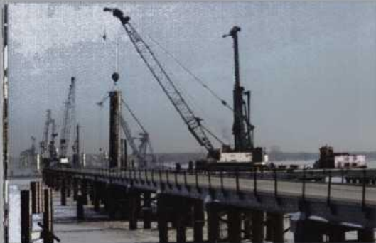
Строительство моста через Каму в Удмуртии
